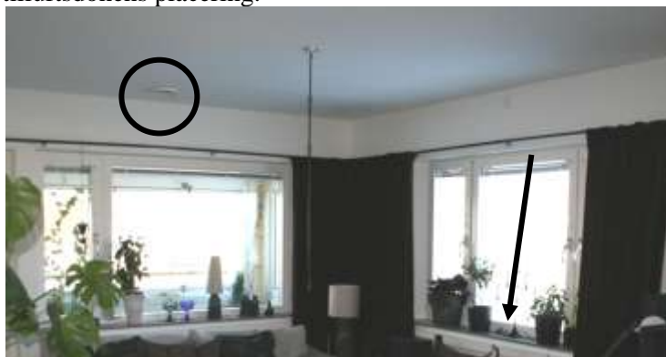
Figur 10 Placering tilluftsdon i vardagsrummet i lägenheten med omställbar ventilation. Tallriksdonet i taket är inringat. Under fönstret finns likadana tilluftsdon som finns i övriga lägenheter
