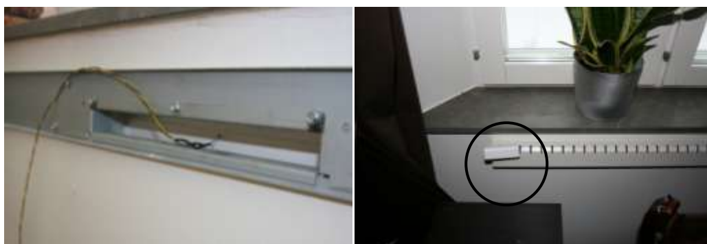
Figur 5. Placering av temperaturgivare i tilluftsdonen. Sensorn har placerats centralt i donet och därefter har skyddsplåten/fördelningsplåten satts på plats igen och temperaturloggern placerats utanpå gallret.
