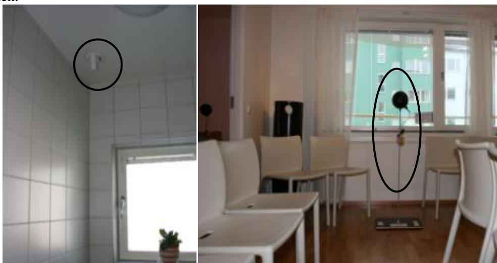
Figur 6. Placering av temperaturgivare i frånluftsdon. De externa sensorn har placerats centralt i luftkanalen och temperaturloggern har sedan placerats utanför frånluftsdonet.
