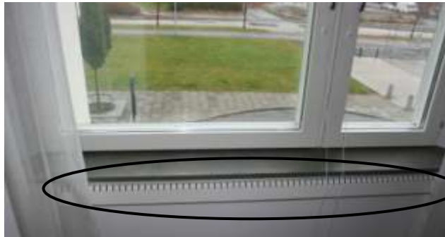
Figur 4. Tilluftsdonets placering under ett fönster. Tilluftsdonet är den skårade listan precis under fönsterbrädet.
